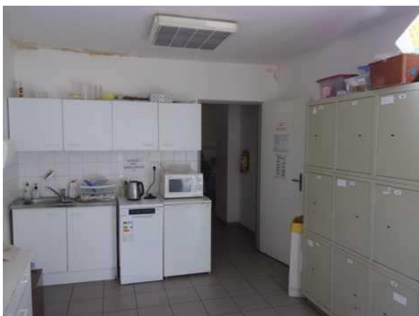
Vlhkost po zatékání ze stoupačky (1.NP kuchyně)
