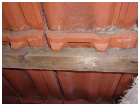
Chybějící pojistná izolace
