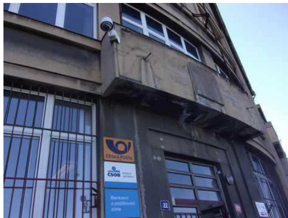
Stopy po protékání vody balkonem
