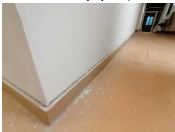
1.PP - sklepní prostory - odvětrání soklu - sanace zdiva
