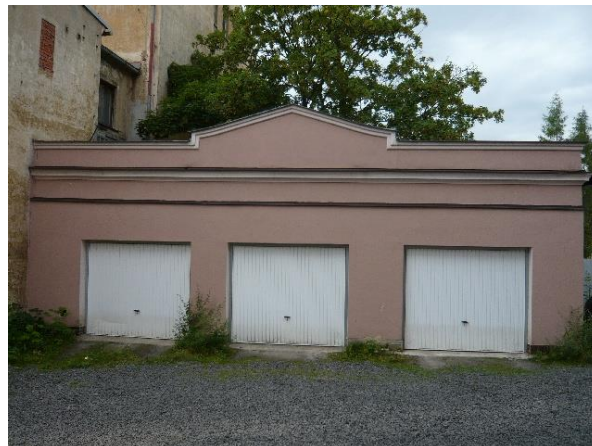
Objekt bez č. p. garáž
