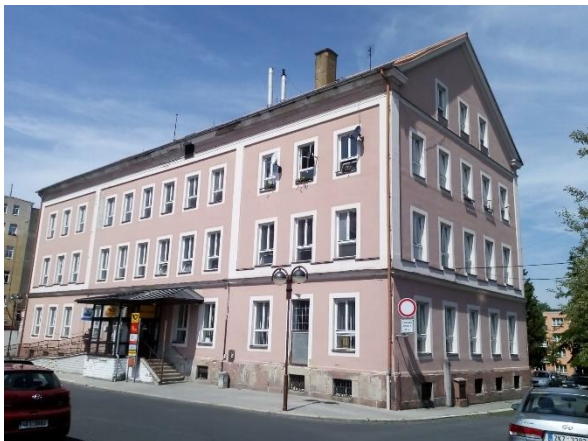
Objekt č. p. 911
